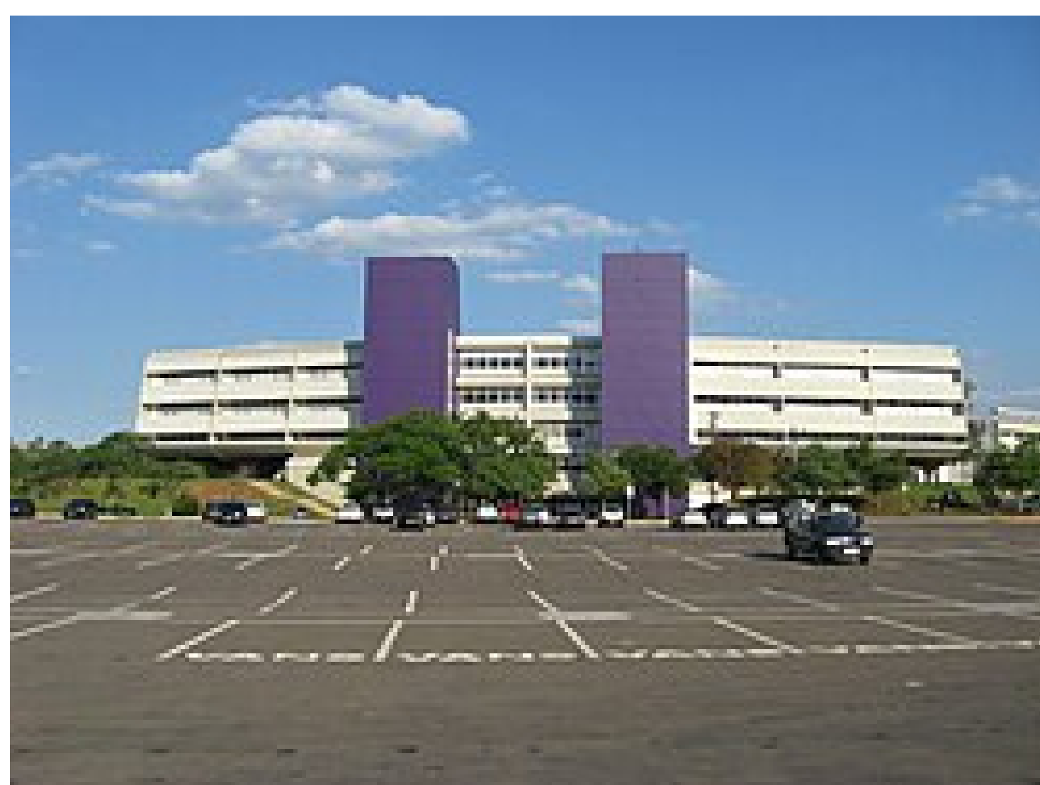
Biblioteca Central César Lattes, na Unicamp, em Campinas FONTE: https://pt.wikipedia.org/wiki/C%C3%A9sar_Lattes
